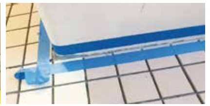
②養生【マスキング】
