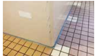
④養生撤去
