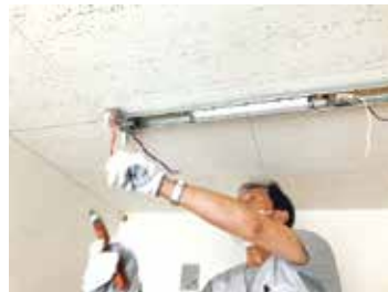
①LED蛍光管への切り替え工事
