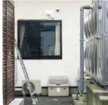
③施設内アプローチ照明 A
