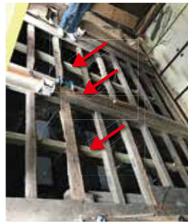
③ 床下補強後
