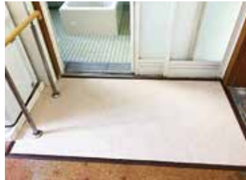
④脱衣室改修後
