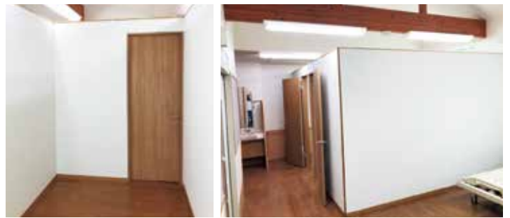
①クロス貼り完了写真
