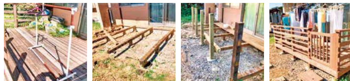
①改修前 ②構造材の状況 ③構造材の補強 ④改修後
